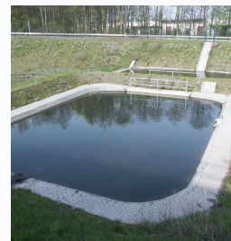
Urządzenia retencyjne są stałym elementem odwodnienia dróg A i S
