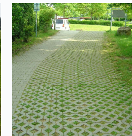
Nawierzchnie przepuszczalne na parkingach
