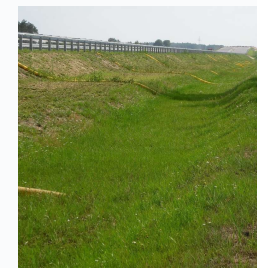
Infiltracja stosowana w sprzyjających warunkach terenowych (A2)
