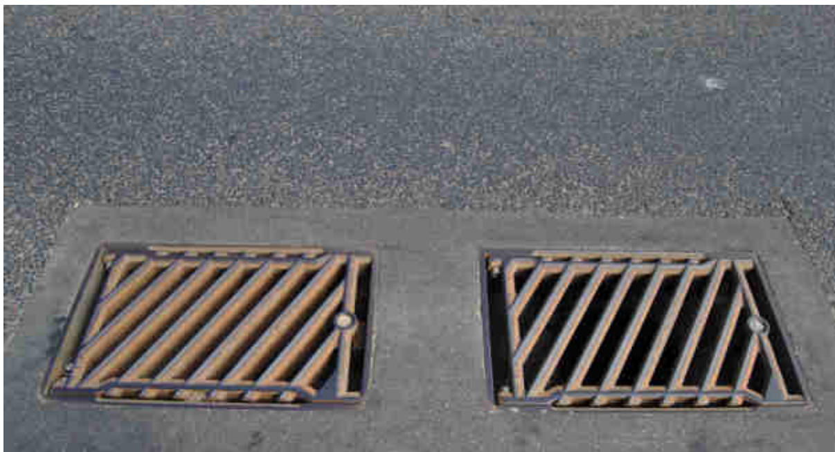
Fot. Nr 3 Wpusty podwójne o wlocie skośnym
