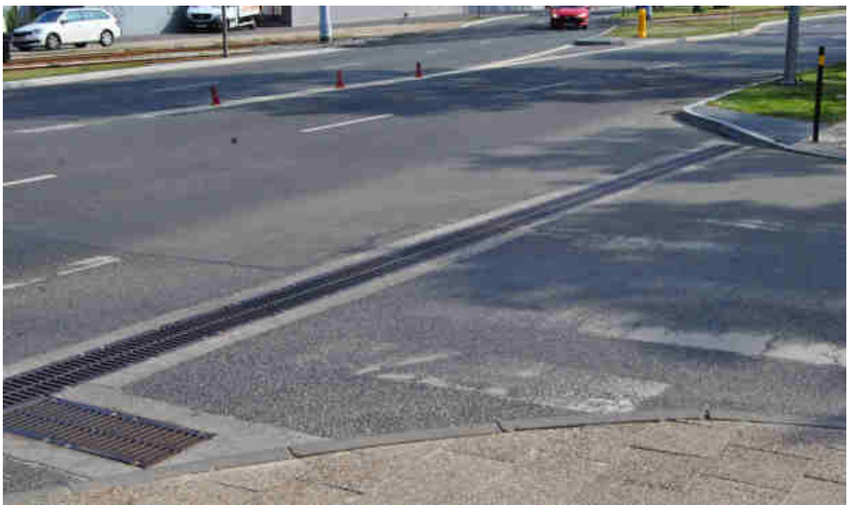
Fot. Nr 6 Odwodnienie w poprzek ulicy
